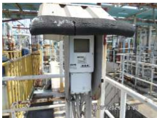
รูปที่ 13 การติดตั้ง COD Online บริเวณระบบบำบัดน้ำเสีย
