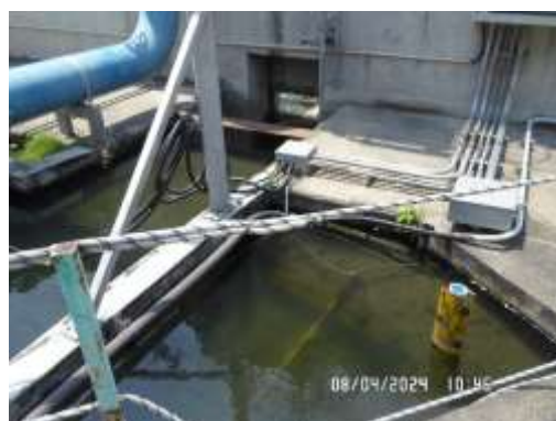
รูปที่ 20 การติดตั้งเครื่องสูบน้ำและบรรทัดวัดระดับน้ำของโครงการ
