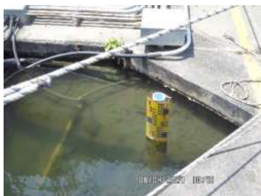
รูปที่ 20 การติดตั้งเครื่องสูบน้ำและบรรทัดวัดระดับน้ำของโครงการ
