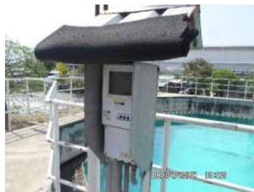
รูปที่ 13 การติดตั้ง COD Online บริเวณระบบบำบัดน้ำเสีย
